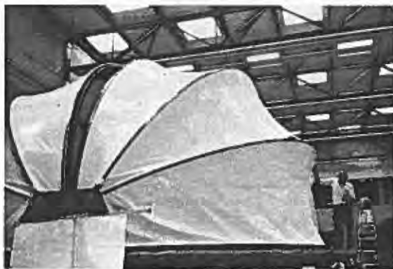
De kap van de DOT in aanbouw. Rechts geeft Piet Hoogendoorn uitleg aan Rob Rutten
