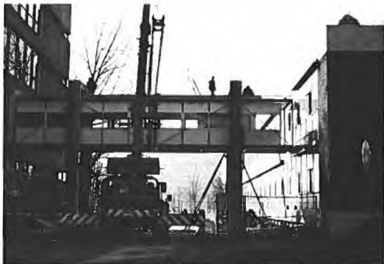
Bouw van de luchtbrug tussen IGF en BBL (foto Evert Landré)
