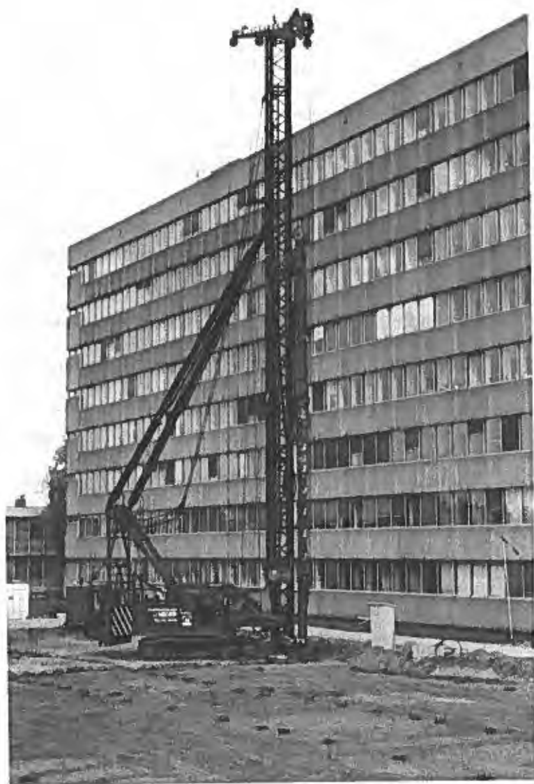
Het heien in volle gang (foto Evert Landré)
