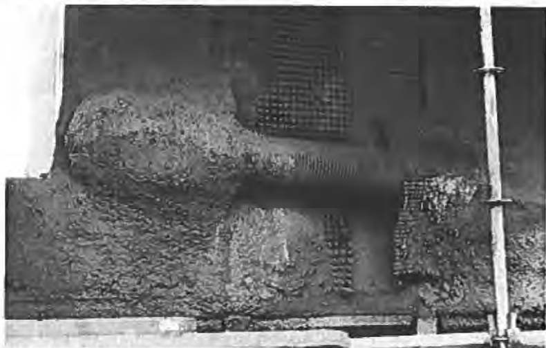
foto 2634 - resultaat van een bewerking met spuitbeton
