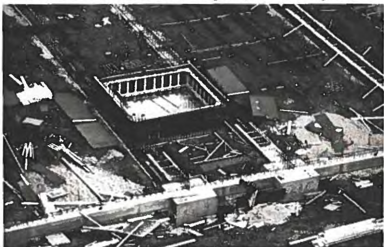
foto 4 - op de gestorte vloer wordt een nieuwe bekisting gemaakt voor het fundament; vooraan is al een fundering van zijn bekisting ontdaan (24 juni)
