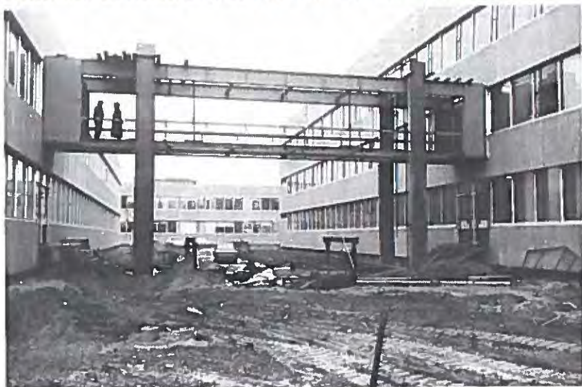
foto 3 - Op deze troosteloze vlakte tussen Generatoren- en KVS-gebouw (rechts) werden de eerste bomen geplant. Onder de loopbrug is het Robert van de Graaff Laboratorium te zien
