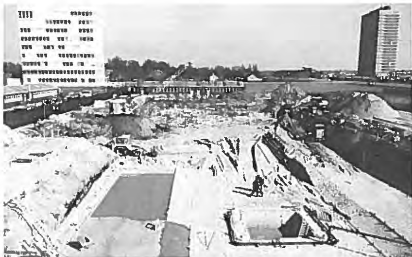
foto 1 - de bouwput van het nieuwe fysisch laboratorium
