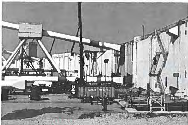
Eén van de twee deuren; de ronde buizen worden vierkant aan de deur gelast. Linksboven een z.g. lashuis
