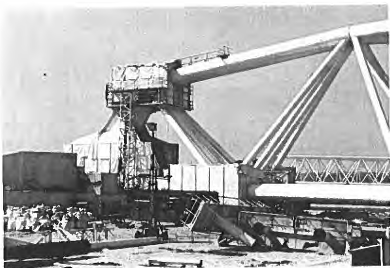
Het balhoofd (I) en het eerste deel van de 237 meter lange arm
