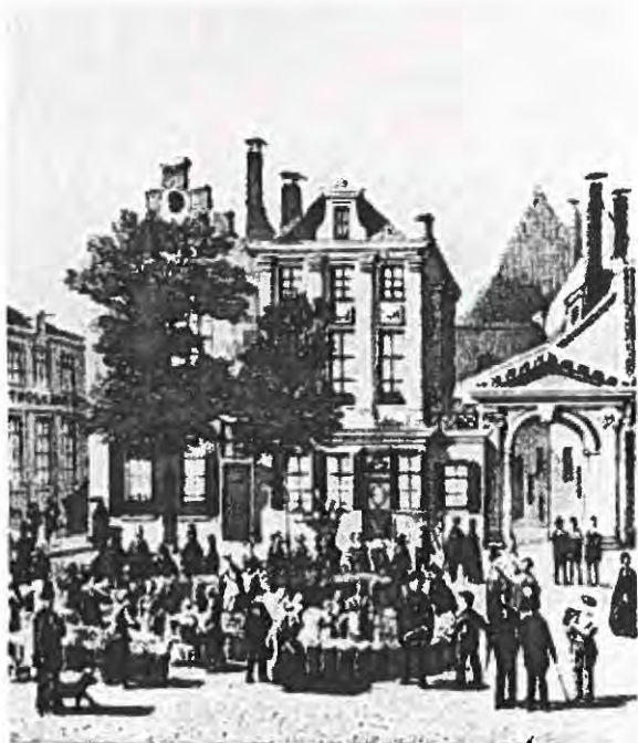
2 - De voorganger van het Fysisch Laboratorium in de Minrebroederstraat
