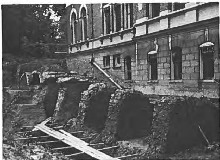
10 - Bij de aanleg van de Van der Graaff-kelder stuitte men, evenals in 1876, op de resten van het oude bolwerk Sterrenburg
