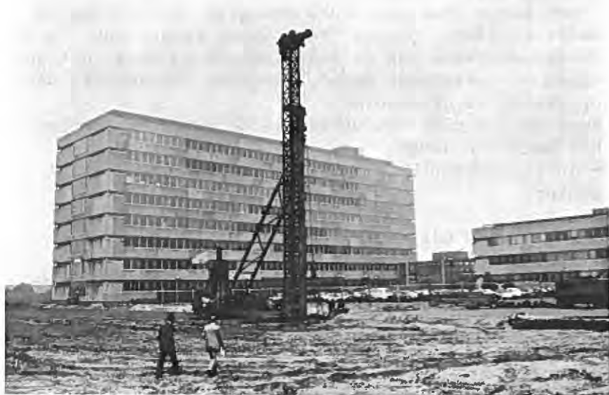
Men slaat "vibropalen" in de grond. Dit zijn in de grond gevormde heipalen.
